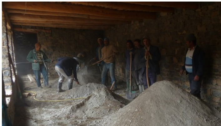
La chape du local municipal est coulée. Gros travail d'équipe.
