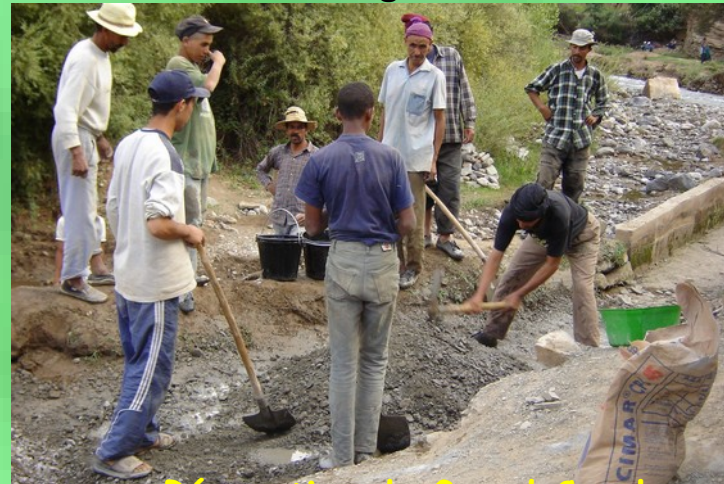
Réparation du Grand Canal
