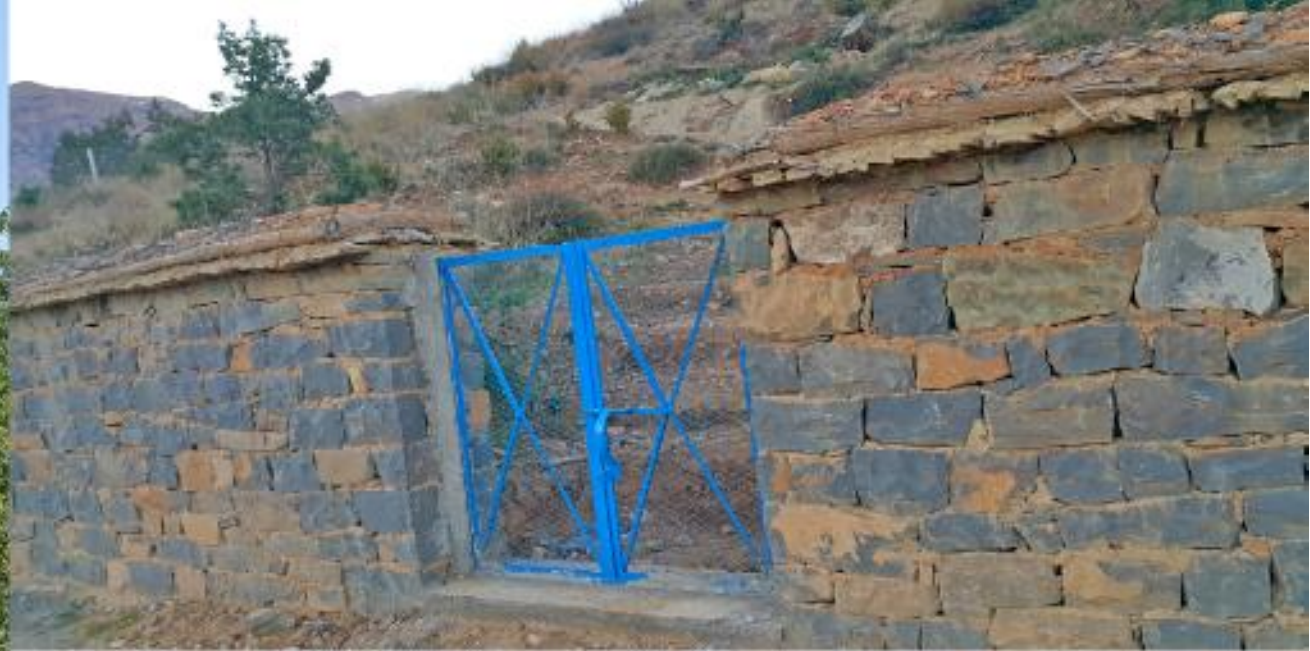
Une demande forte des habitants : la clôture et la pose des grilles du cimetière. Travaux terminés début 2019.
