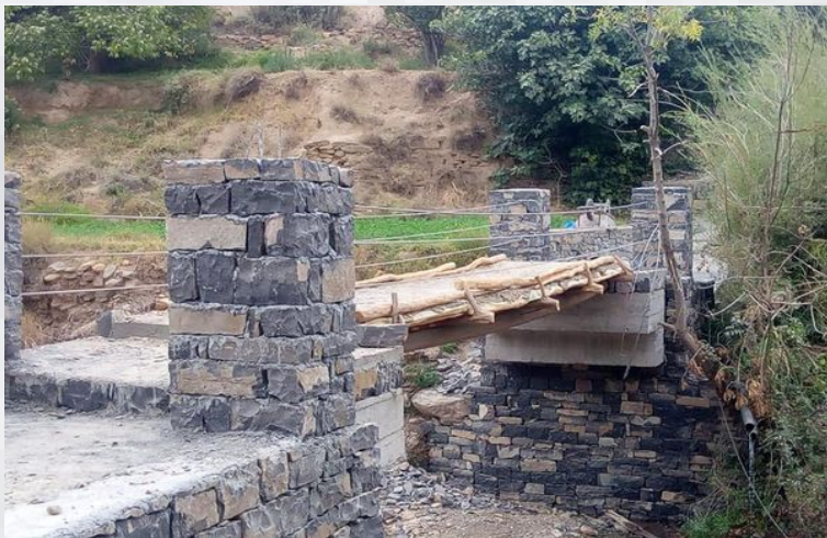
Amezray : la passerelle
